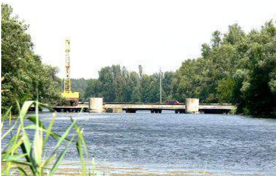
Чергова реконструкція мосту на р. Вільшанці.
